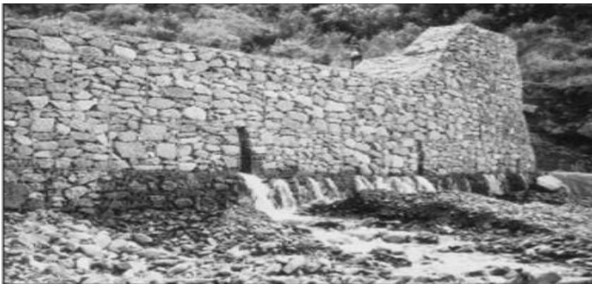
**Figura 5** - Detalhe da característica de ser autodrenante, passagem de água dentro da estrutura de gabiões.
