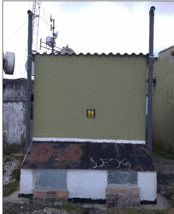
Figura 02 - Unidade SaniSeCo Pico do Itambé (MG)
