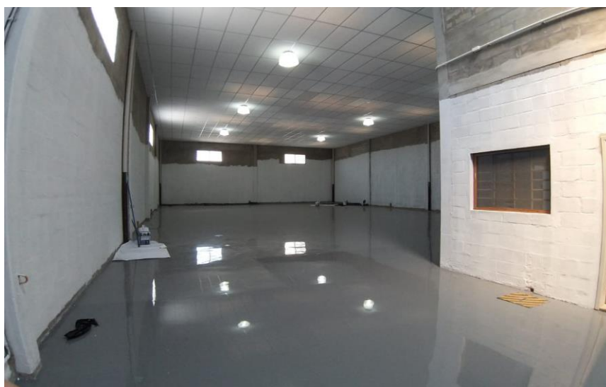
Imagem 3 - Pintura em andamento.
