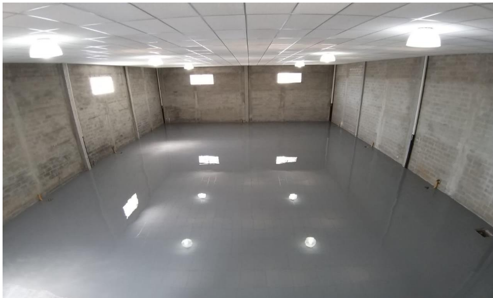
Imagem 2 - Instalação do Piso
