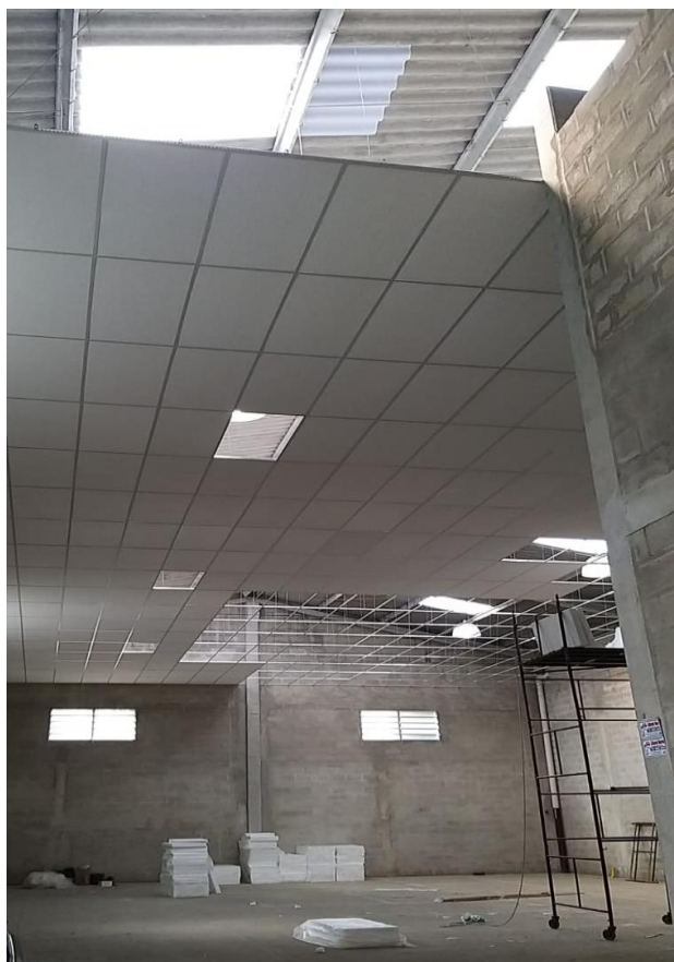
Imagem 1 - Instalação do forro de EPS.
