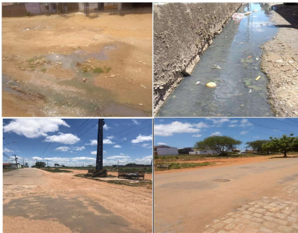
Figura 1 – Pavimentação precária das ruas do bairro Planalto – Natal/RN
